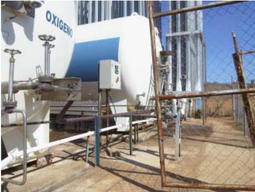
Depósitos de Oxígeno licuado con Sonda de presión en la base para control de peso.
